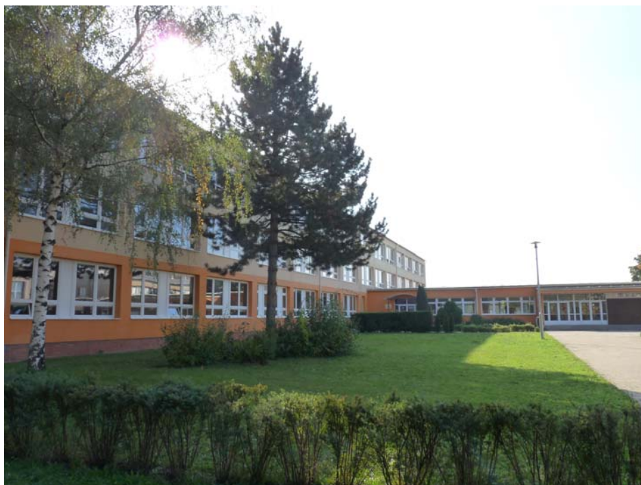
Čelní pohled na opravenou školu
